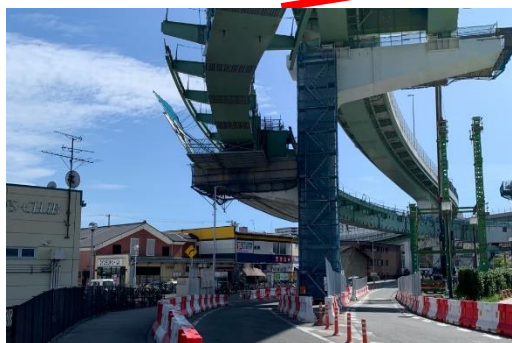
④橋桁の設置
