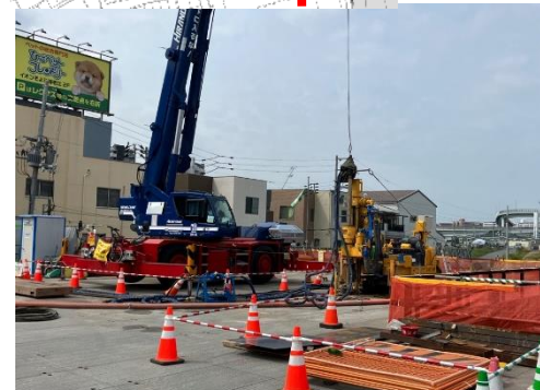
⑥地盤改良工
