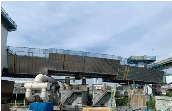
①橋桁の設置
