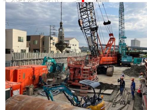
⑥下水幹線撤去工
