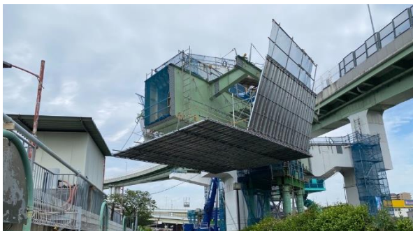
①橋桁の設置
