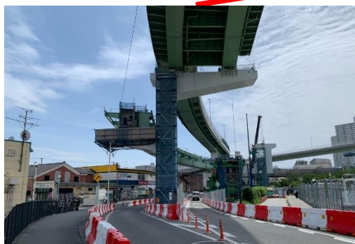
④橋桁の設置
