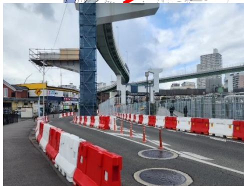
④橋桁設置の準備作業
