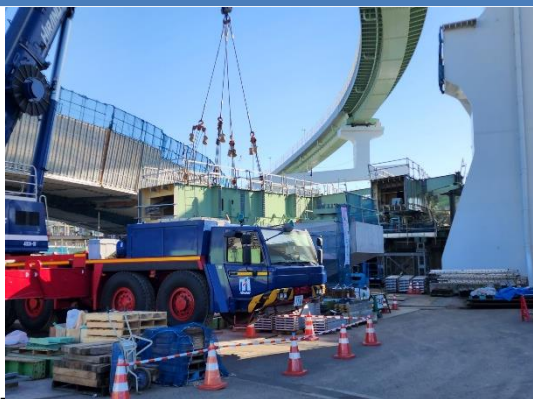
①橋桁の設置
