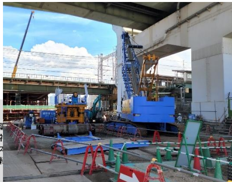
② 基礎杭の設置
