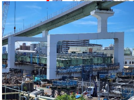
④ 橋桁の設置
