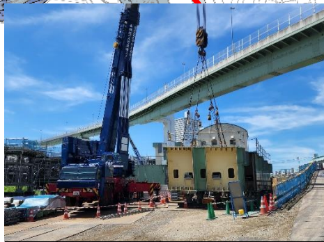
⑤ 橋桁の設置
