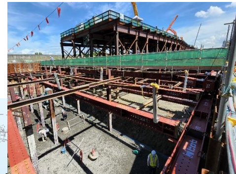
③ トンネルの掘削
