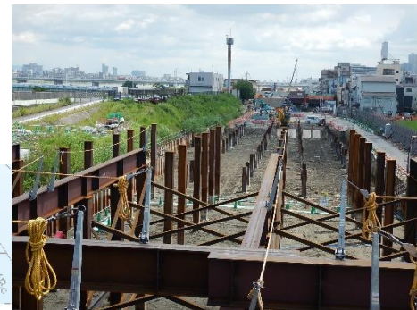
④ トンネルの掘削
