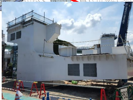
⑥ 橋脚の設置
