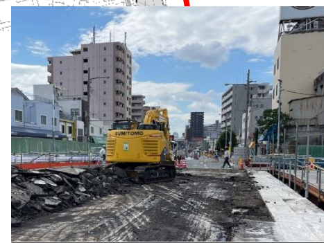
⑧ 既設橋梁撤去
