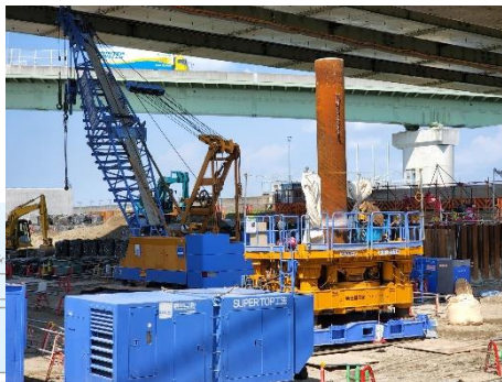
③ 基礎杭の設置
