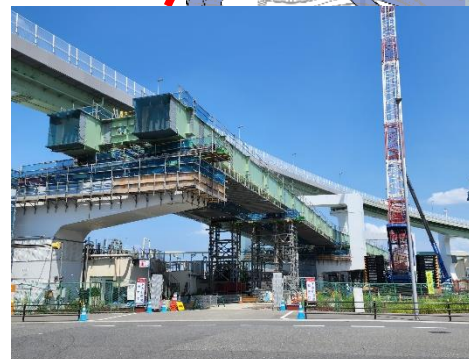
⑤ 橋桁の設置
