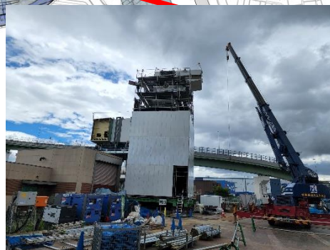
⑥ 橋脚の設置
