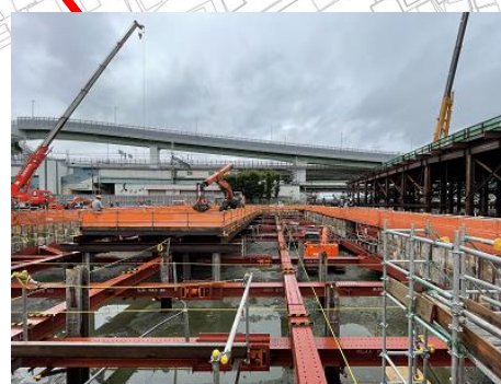
⑦ 換気所掘削
