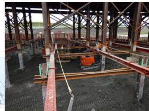
④ トンネルの掘削
