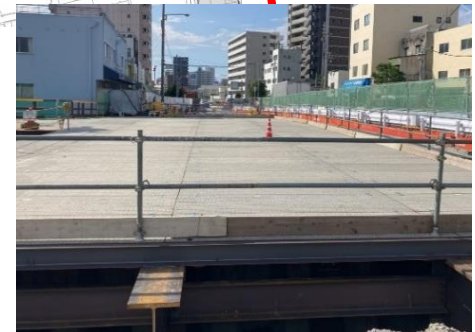
⑧ 栈橋設置完了
