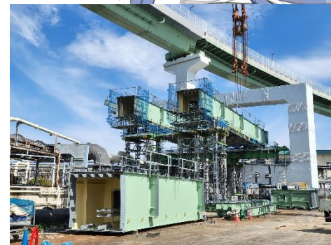
⑤ 橋桁の設置
