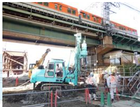
③ 基礎杭の設置
