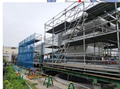
⑤橋脚の設置
