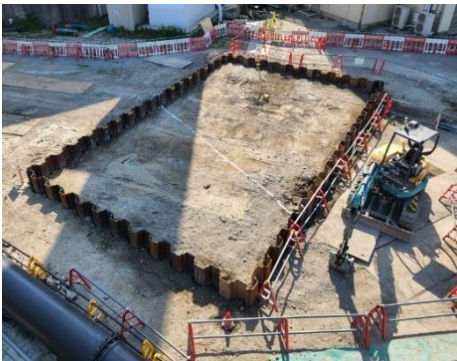
①鋼矢板の設置
