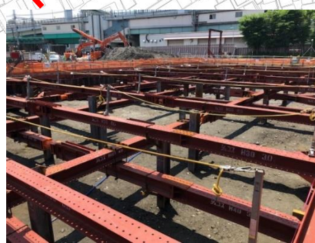
⑦換気所掘削
