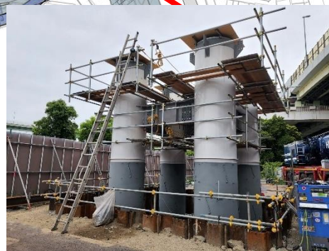
⑥橋脚の設置
