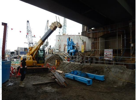
鋼矢板の設置
