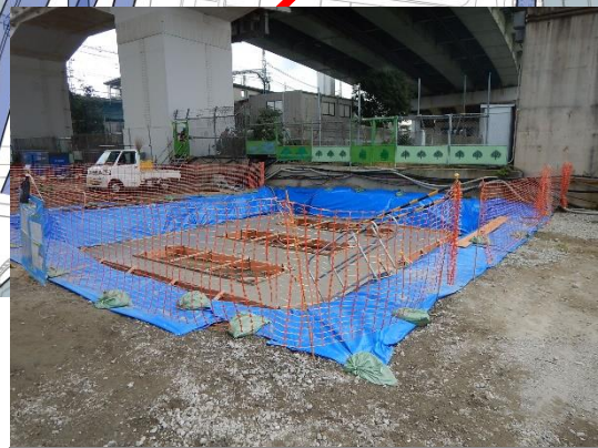
橋台基礎の掘削
