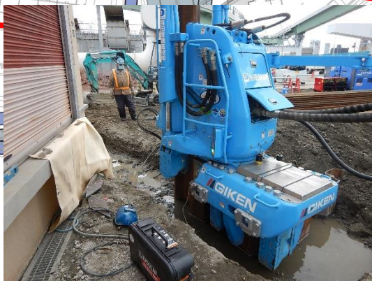
鋼矢板の設置
