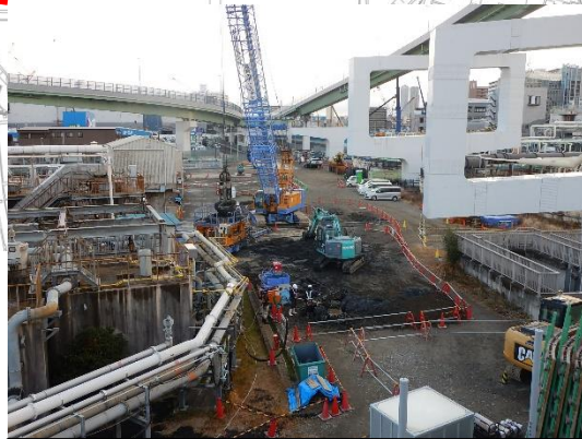
地中障害物撤去
