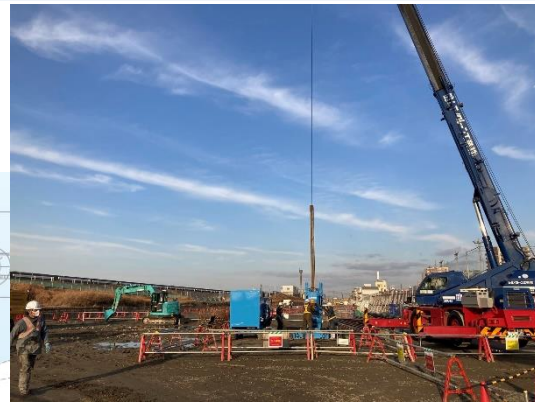
鋼矢板の設置
