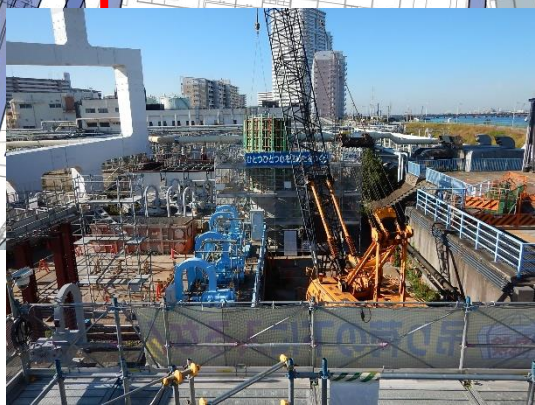
橋梁基礎の構築
