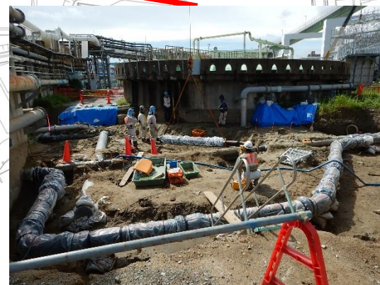
埋設管の移設
