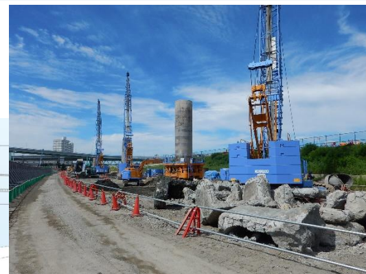
旧下水道の撤去
