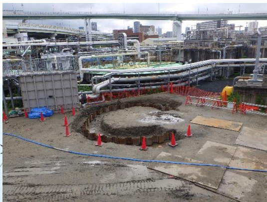
鋼矢板の設置
