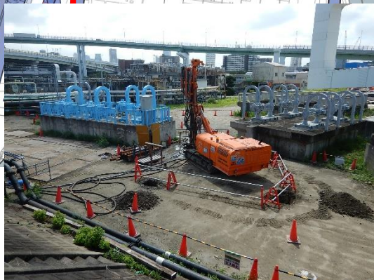
橋梁基礎の構築
