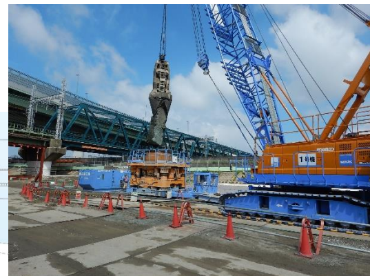
旧下水道の撤去
