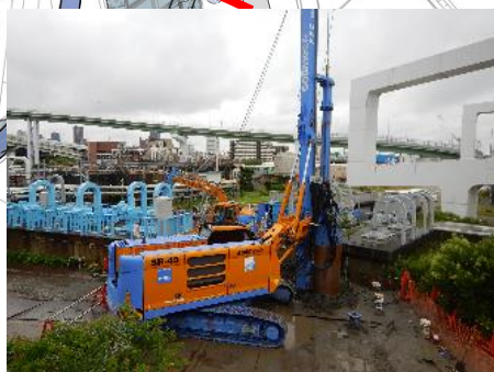
地中障害物撤去
