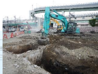
工場の基礎撤去
