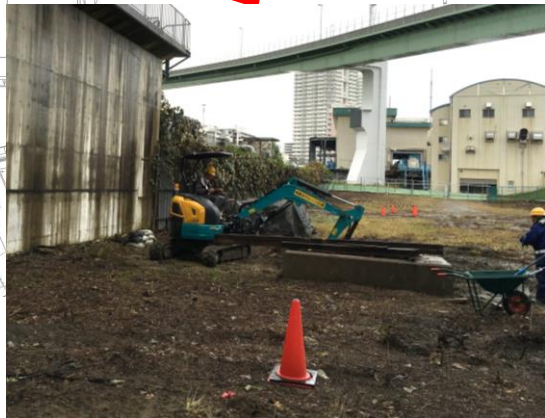
橋梁基礎部の試掘作業
