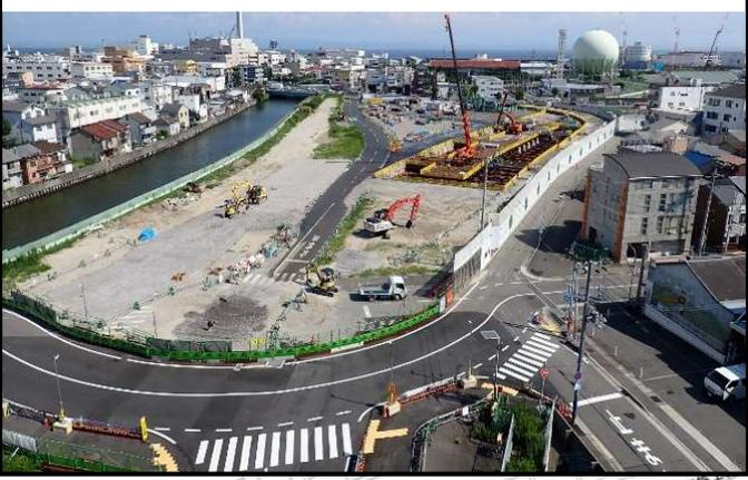
② 開削トンネルの掘削工事を実施しています。(4ブロック・5ブロック)
