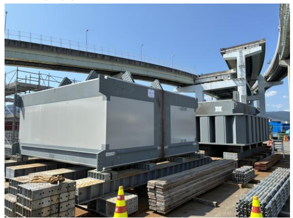
【1】橋脚工事(PPE-1)において、鋼製橋脚の搬入および地組中。
