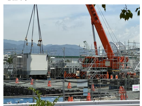
【2】橋脚工事(PPE-4)において、鋼製橋脚の搬入および地組中。
