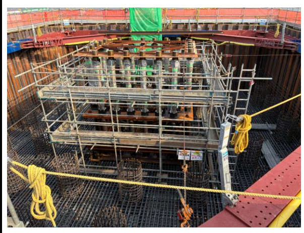
【3】橋脚工事(PPE-5L)において、頂版鉄筋構築中。
