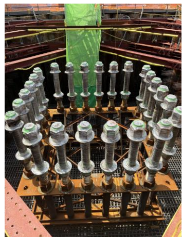
【2】橋脚工事(PPE-2)において、アンカーボルト設置完了。
