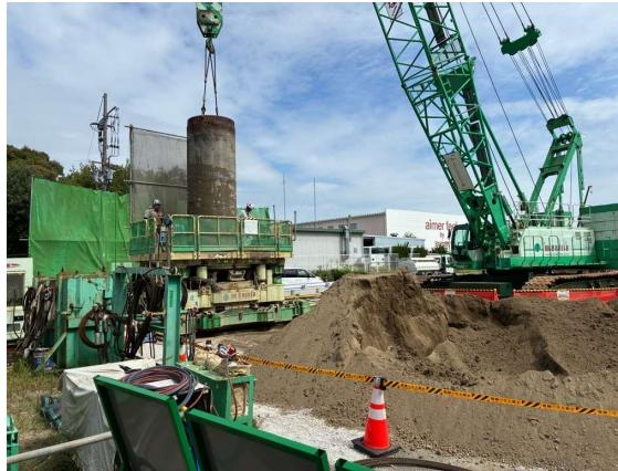
【2】橋脚工事(PPE-2)において、鋼管矢板打込中
