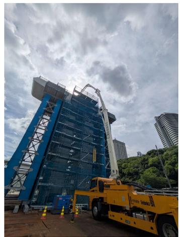
**【2】橋脚工事(PPE-7)において、頂版コンクリート打設完了**
