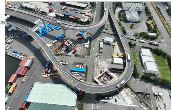
写真③ PPE-1 鋼製橋脚地組中 PPE-2 頂版コンクリート打設完了
