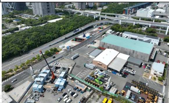
写真② PPE-3 埋戻し完了 PPE-4 鋼製橋脚地組中
