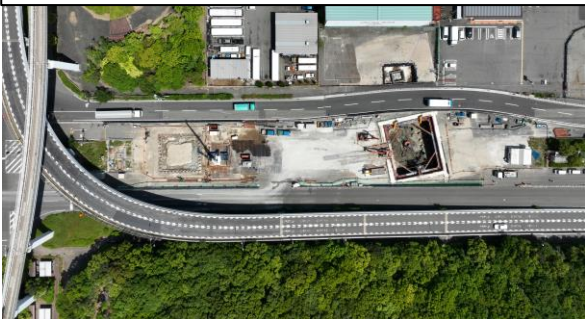
写真① PPE-5R 鋼矢板引抜完了 PPE-5L 頂版鉄筋構築中 PPE-6 頂版鉄筋構築中
