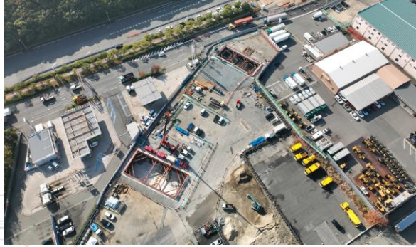
写真② PPE-3 頂版鉄筋構築中 PPE-4 頂版コンクリート打設完了
