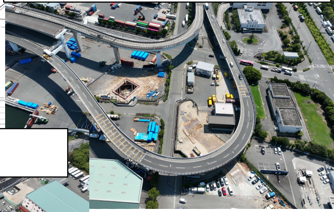
写真⑤ PPE-1 頂版鉄筋組立中 PPE-2 鋼管矢板打込中
