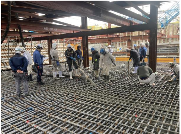
【1】施工区間① 3ブロック 頂版コンクリート打設状況
