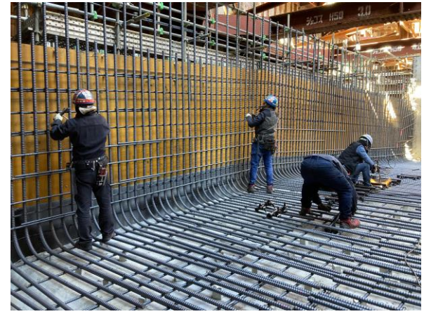
【2】施工区間④ 10-2ブロック 底版下筋組立状況
