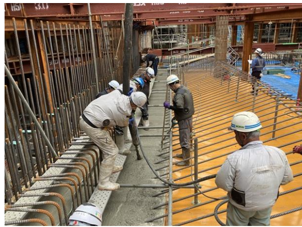
【1】施工区間④ 10-1ブロック ダクト部側壁コンクリート打設状況
