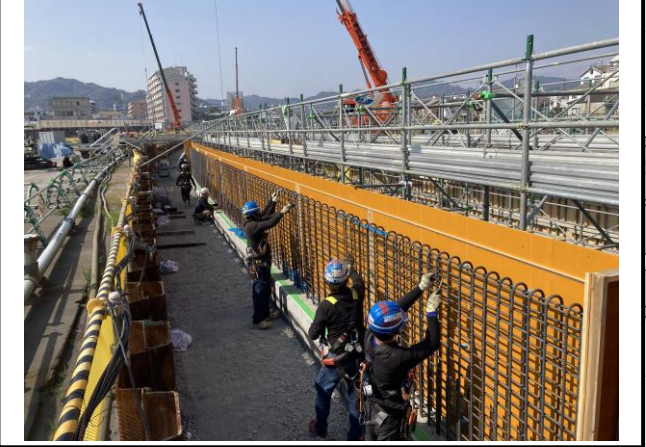
【2】施工区間⑤ U-4ブロック 側壁上部鉄筋組立状況
