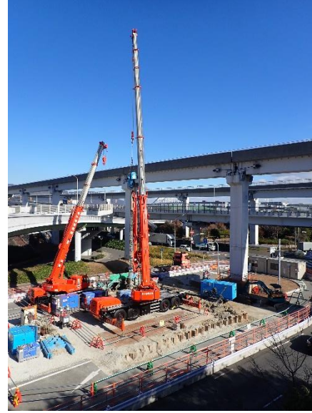
【2】高速道路の橋脚(PPE-7)基礎工事に おいて、影響遮断矢板の設置中。
