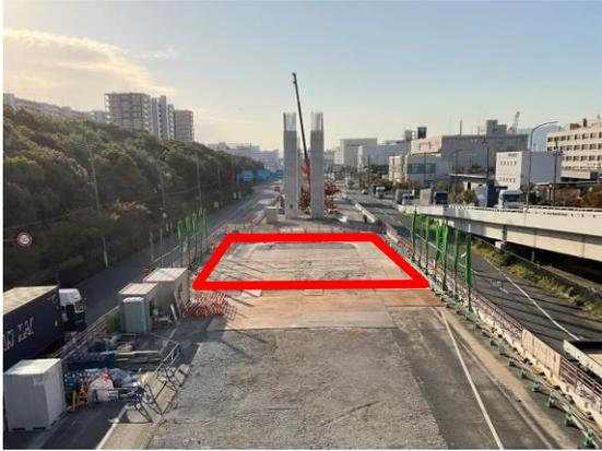
【2】高速道路の橋脚(PPE-4)基礎工事に於いて、引き続きオールケーシング工法を用いて地中障害物の撤去中。
