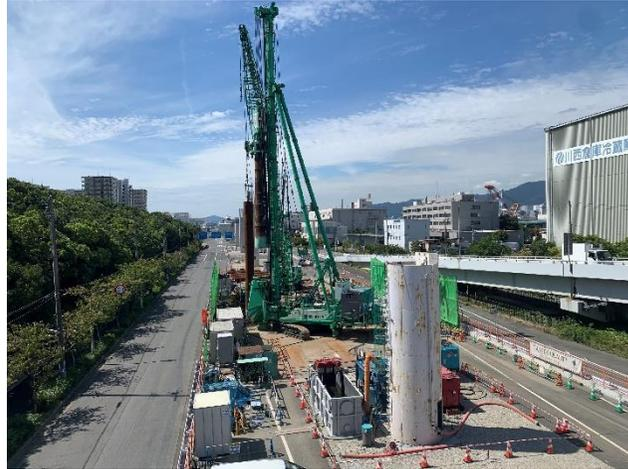
② 高速道路の橋脚(PPE-4)基礎工事に於いて、オールケーシング工法を用いて地中障害物の撤去中。
