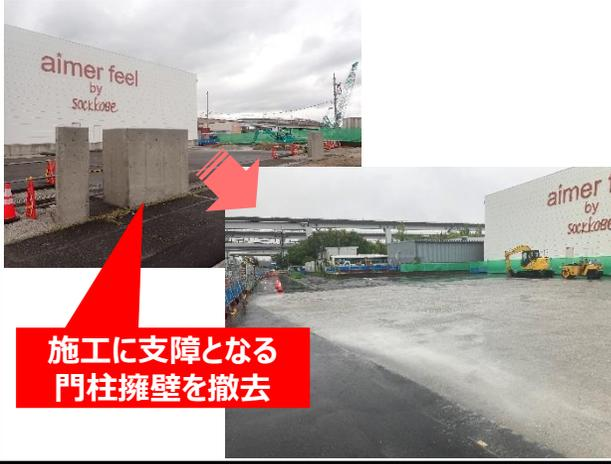
② 高速道路の橋脚(PPE-2)基礎工事に先立ち、施工ヤード確保のため、代替駐車場を整備完了。
