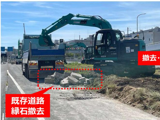
② 中央分離帯(植樹帯)の樹木や縁石等の撤去が完了し、工事施工ヤードが完成。(PPE-7付近)
