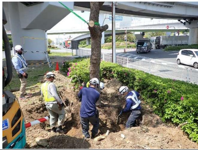
②橋脚の基礎と抵触する雨水管の移設工事を実施しています。(PPE-5付近)
