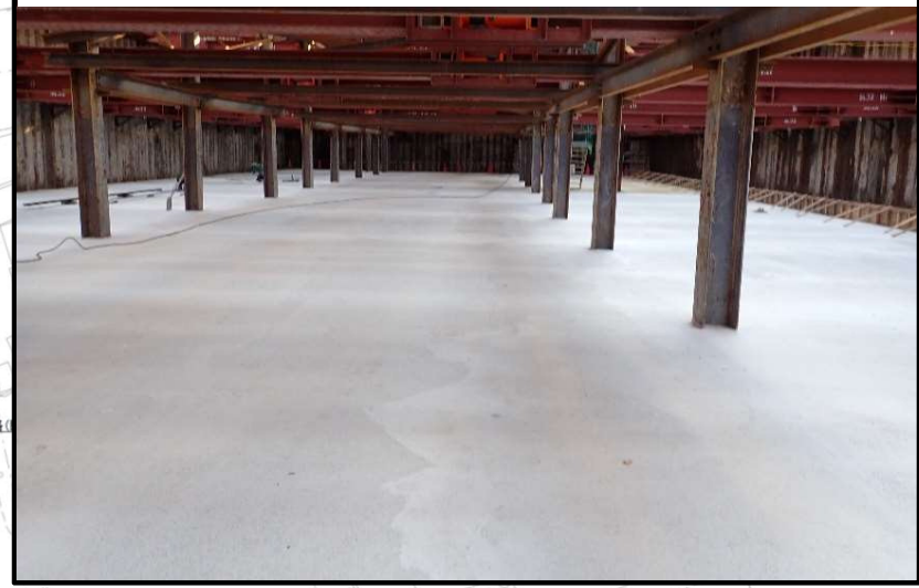
② 開削トンネルの掘削工事を実施しています。 (5ブロック 均しコンクリート打設完了)
