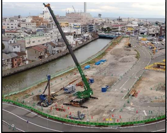
① 開削トンネルの掘削工事に向けての準備工 (雨水幹線の移設)を実施しています。
