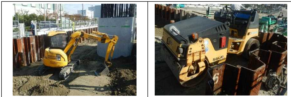
図 5-9 建設機械の稼働状況
