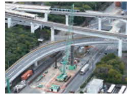
六甲ライナー近接の基礎杭工事
