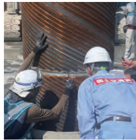
鋼管杭の継ぎ目の溶接を確認中
