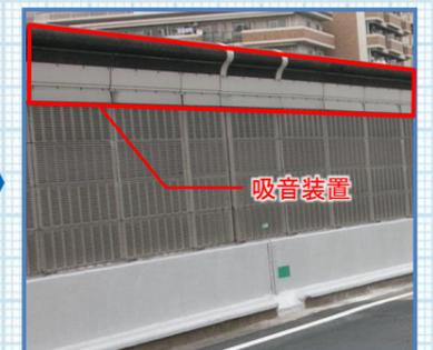
改築後は壁高欄、遮音壁の上にさらに吸音装置を設置
