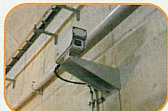
▲トンネル内カメラ
