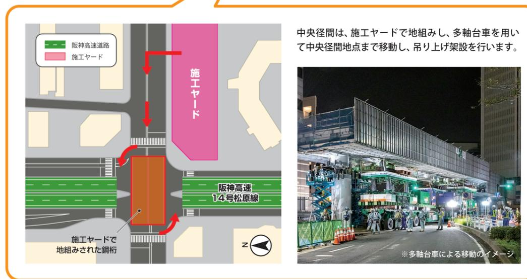
中央径間は、施工ヤードで地組みし、多軸台車を用いて中央径間地点まで移動し、吊り上げ架設を行います。
