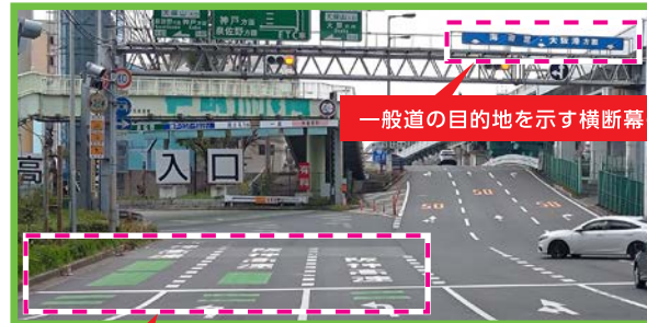
高速入口を示すカラー舗装の明瞭化
