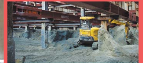
土砂掘削の状況 Excavation site
