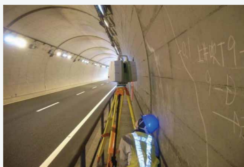
監査路上で計測(規制なし)
