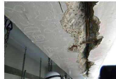
橋脚の鉄筋破断
