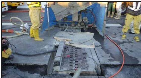
伸縮継手をワイヤーソーで切り取る工法
