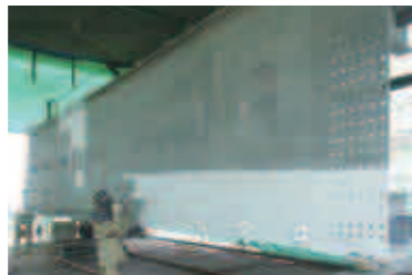
橋梁の金属溶射
