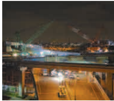
国道1号(寝屋川バイパス)上鋼桁架設
