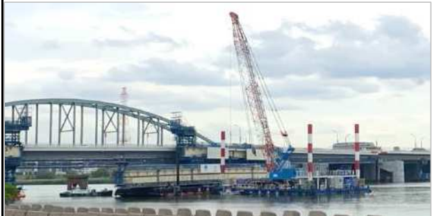
<桁架設状況(河川部)>
