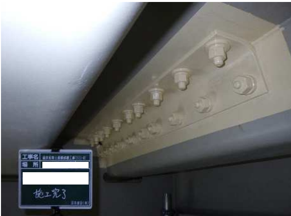
スタッドボルトを用いた当て板工法
