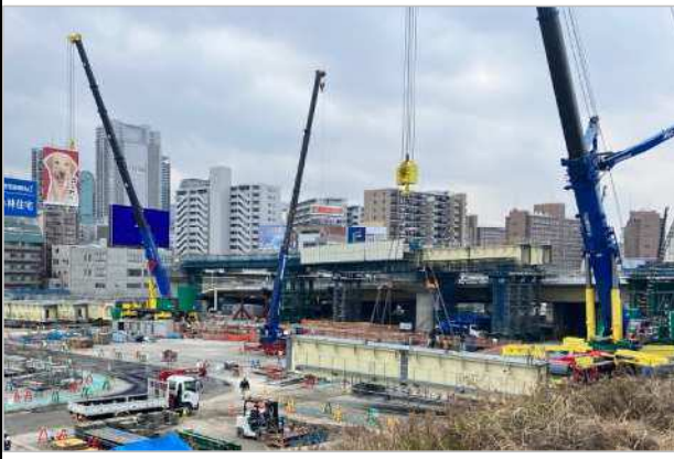
<桁架設状況(陸上部)>
