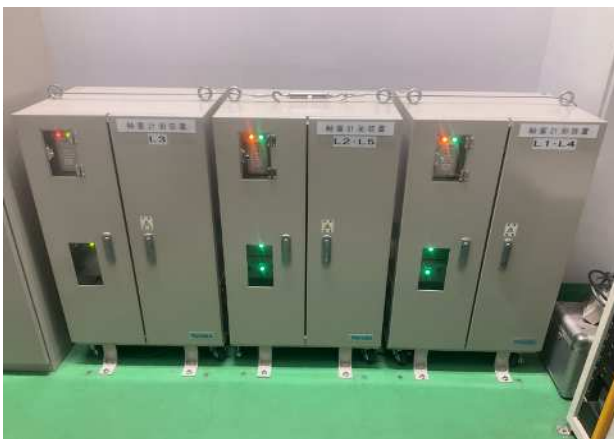
重量計測装置(施工後)
