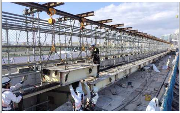
<吊運搬設備を用いた既設桁の撤去状況>
