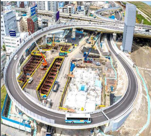
<現場全景(陸上部)>
