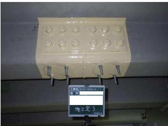
Uリブ突合せ溶接部の当て板工法
