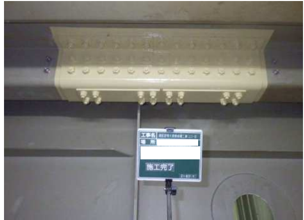
スタッドボルトを用いたUリブ取替工法
