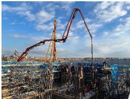
受電所の建築工の実施状況
