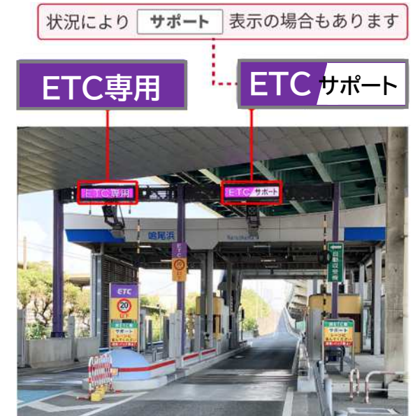
ETC専用料金所 (写真:5号湾岸線 鳴尾浜料金所)
