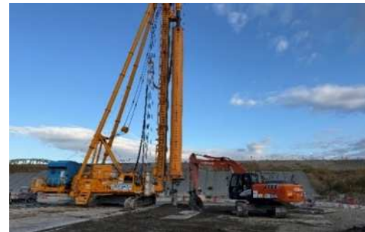
地盤改良工の実施状況
