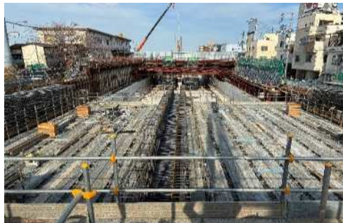
開削トンネル工事実施状況
