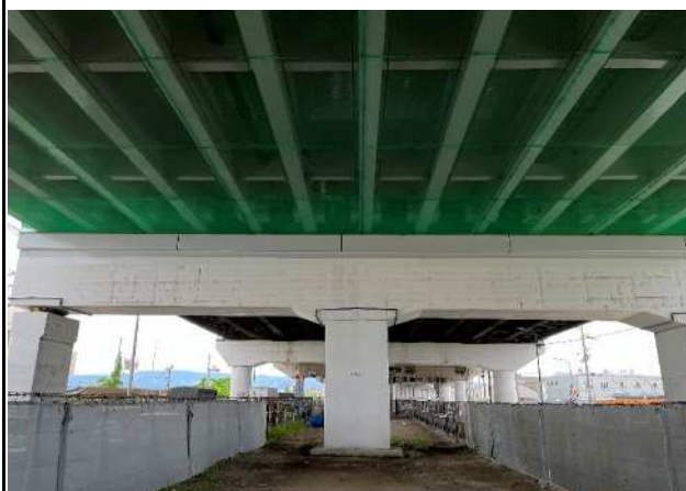
外ケーブル工及び鋼板接着工完了
