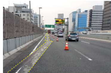
道路上縦目地解消状況
