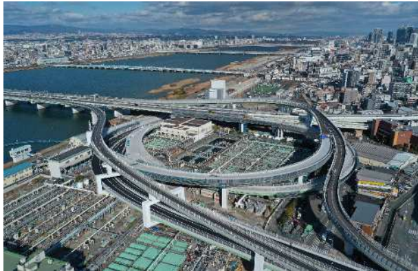
現場全景(海老江ジャンクション)
