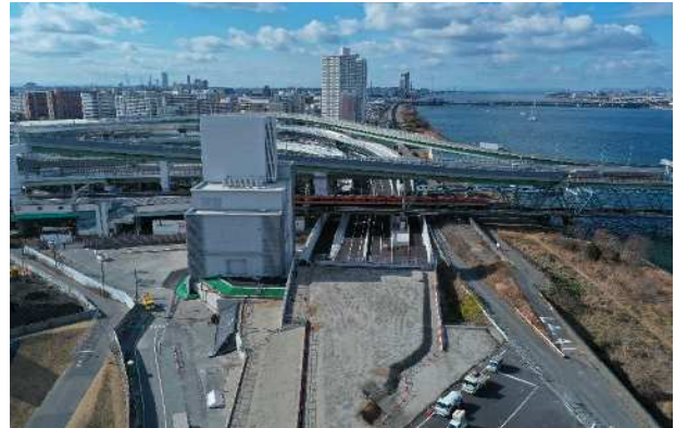
現場全景(3号神戸線交差部)
