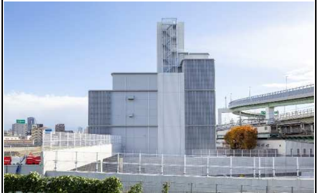
建物全景(北側より)
