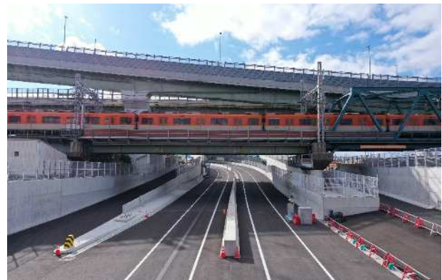
土工擁壁区間
