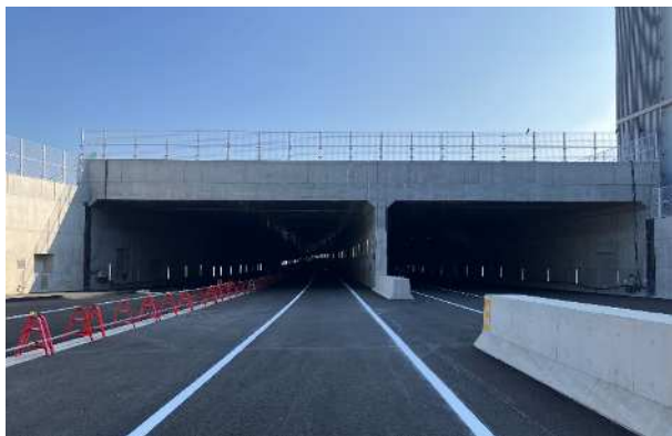
開削トンネル区間
