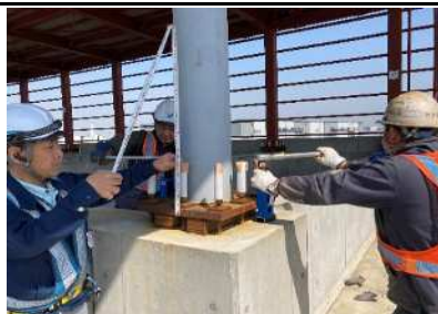
ジャッキアップ 工事
