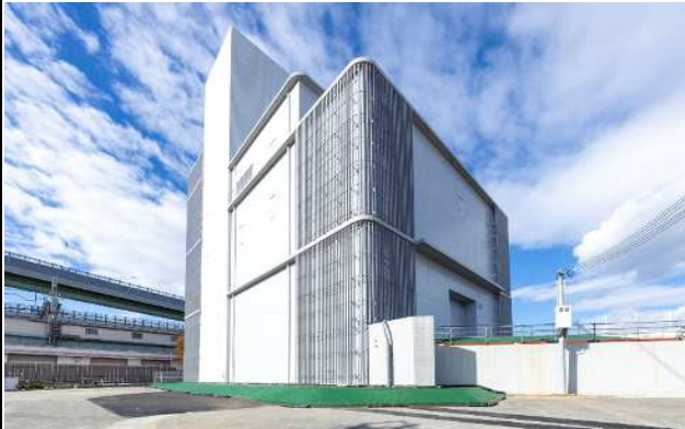
建物全景(南東側より)
