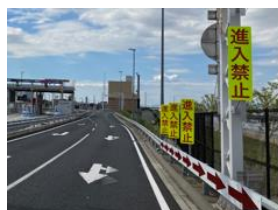
進入禁止看板の 連続設置
