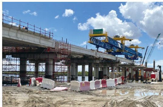
建設中のモンバサ南バイパス(ケニア)
